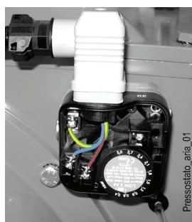
检查燃气压力的气压保持器（最小与最大）目的是当燃气压力没有达到预期数值时阻止燃烧器运转。
